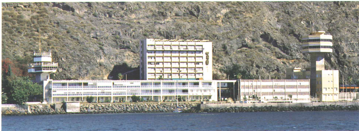
Centro Superior de Náutica. Casa del Mar. Capitanía Marítima y Torre de Control de Tráfico Marítimo.
