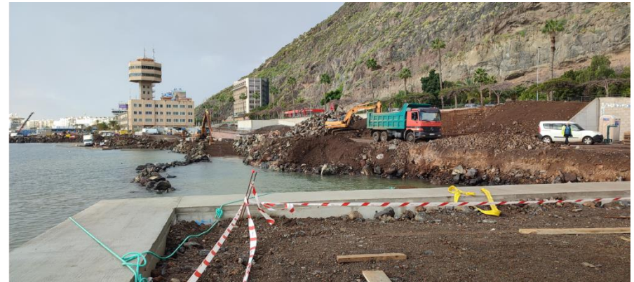
Visita a la zona de obras.
