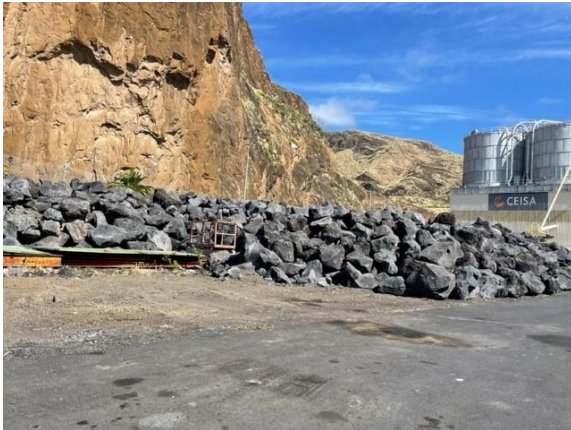
Escollera de protección en zona de acopio
