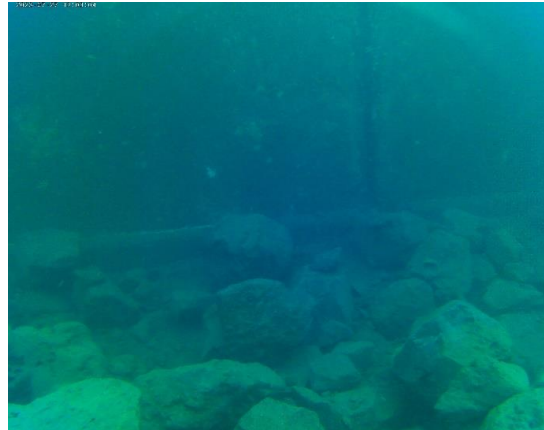
Inspección de buzos de la escollera vertida
